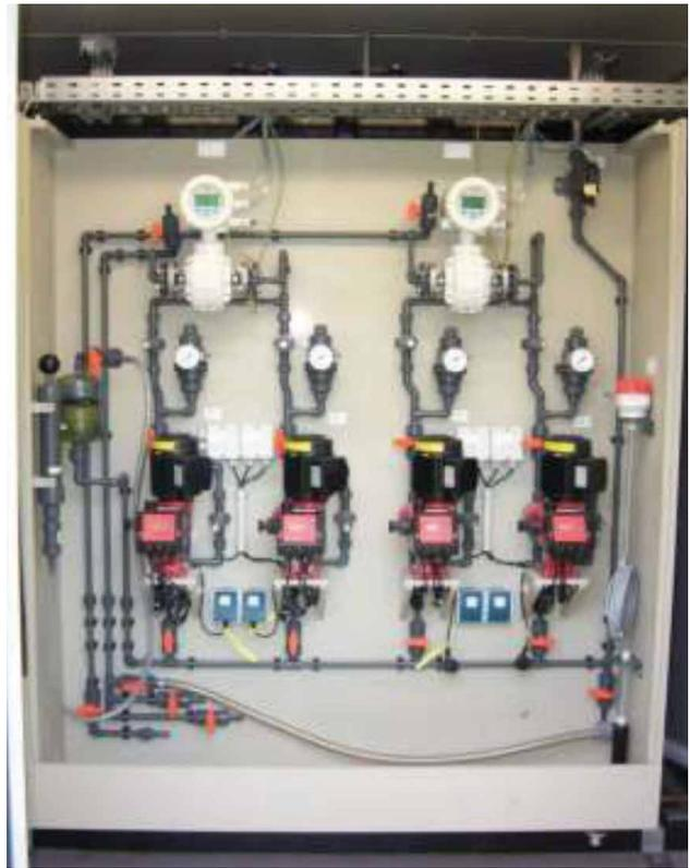
Dosierpanel mit allen erforderlichen Armaturen, Sicherheitseinrichtungen und Aggregaten für bis zu 4 Dosierpumpen
