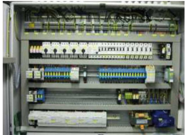
Elektrische Schalt- und Steueranlage mit Speicherprogrammierbarer Steuerung (SPS) zur Steuerung und Überwachung der gesamten Anlage.
