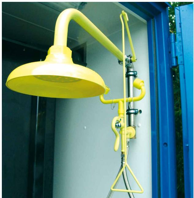
Schwenkbare Körpernotdusche mit flexibler Augendusche
